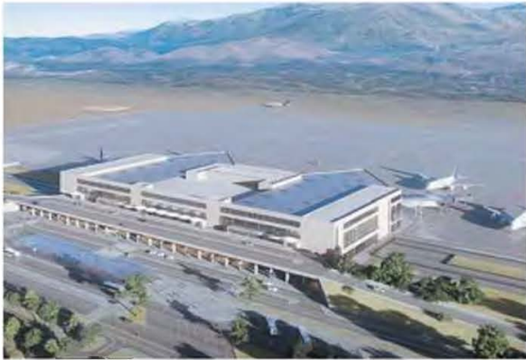
► Το νέο αεροδρόμιο στο Καστέλλι θα είναι το πιο σύγχρονο της Ελλάδας και από τα πιο σύγχρονα της Νοτιοανατολικής Ευρώπης
