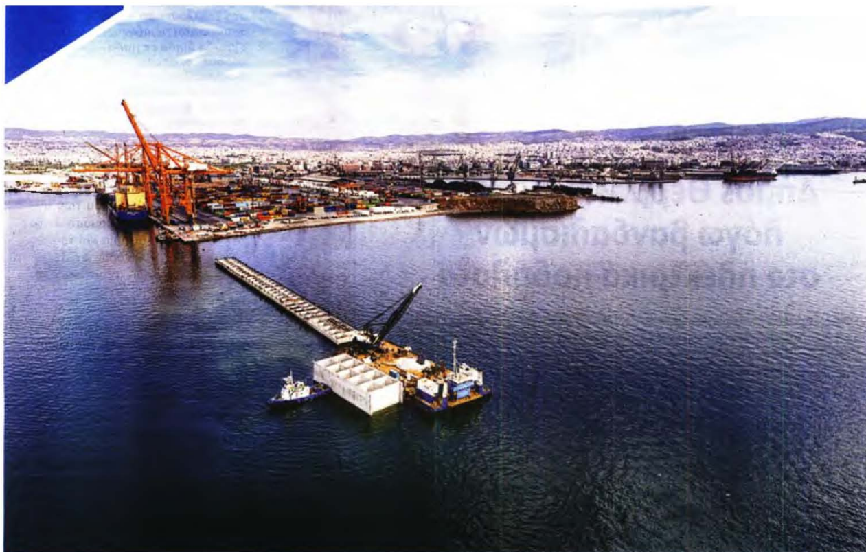
Η τοποθέτηση των caissons εκτιμάται ότι θα ολοκληρωθεί μέσα στους επόμενους πέντε-έξι μήνες
