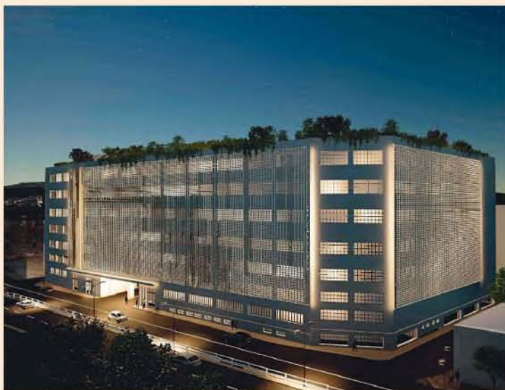
Στο παλαιό εργοστάσιο της «Κρόν» επί της οδού Περικλέους...
