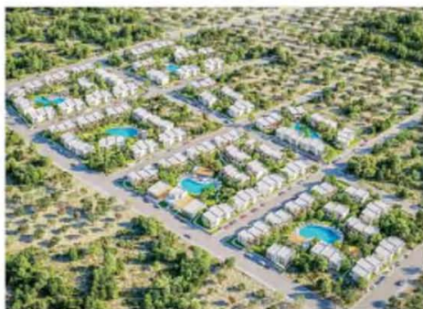
Το κύριο μέρος του «Oliville Halkidiki» της τουρκικής Ege Yapı αφορά την κατασκευή συγκροτήματος 178 επιπλωμένων βιλών.
