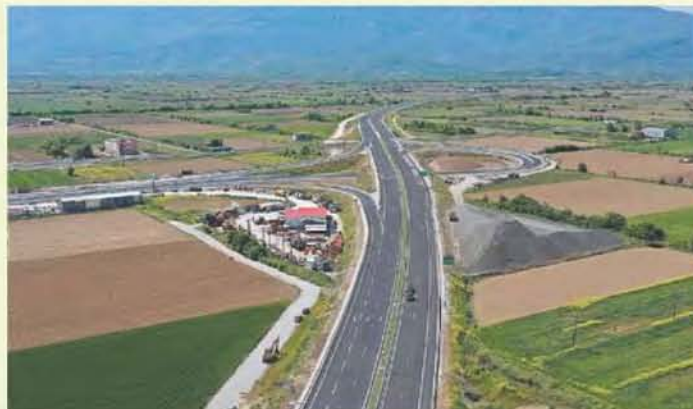
Με τον Ε65 το ταξίδι από τη Λαμία έως και την Εγνατία Οδό θα διαρκεί μόλις 1 ώρα και 45 λεπτά, η απόσταση Αθήνα-Γρεβενά και Αθήνα-Μέτσοβο θα μειωθεί σε μόλις 4 ώρες και η μετάβαση στην Καστοριά και στην Κοζάνη θα είναι υπόθεση 4,5 ωρών
