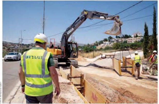
Εργασίες κατασκευής δευτερεύοντος δικτύου Δήμου Παλλήνης.
