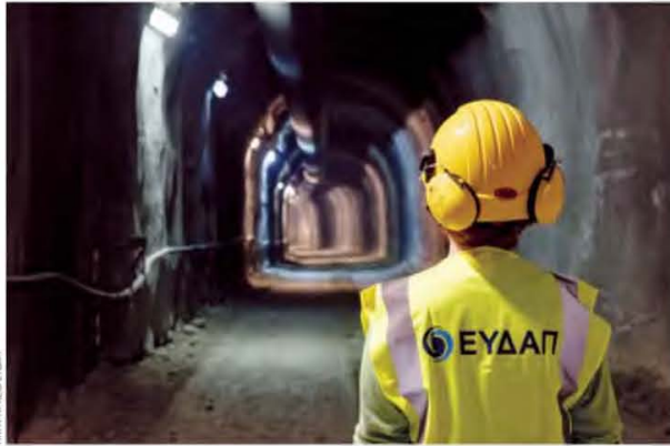
Εργασίες κατασκευής σήραγγας του ΚΕΛ Ραφίνας - Πικερμίου και Σπάτων - Αρτέμιδας.
