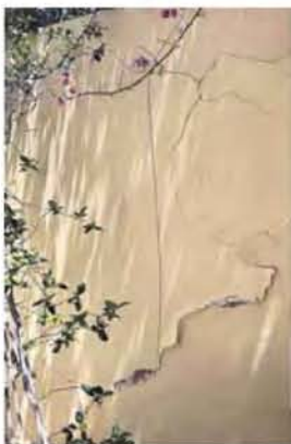
► Φωτογραφίες κατοίκων που παραχωρήθηκαν στα «ΝΕΑ», με τις εμφανείς ρωγμές που παρατηρήθηκαν κατά τις εργασίες του μετροπόντικα σε διάφορες κατοικίες στην περιοχή της Κυψέλης και έχουν αναστατώσει τους κατοίκους
