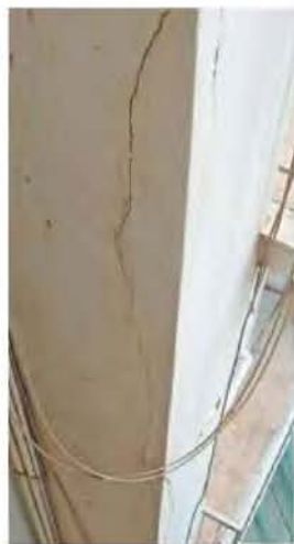
► Φωτογραφίες κατοίκων που παραχωρήθηκαν στα «ΝΕΑ», με τις εμφανείς ρωγμές που παρατηρήθηκαν κατά τις εργασίες του μετροπόντικα σε διάφορες κατοικίες στην περιοχή της Κυψέλης και έχουν αναστατώσει τους κατοίκους
