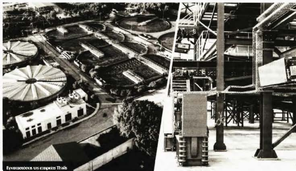
Εγκαταστάσεις της εταιρείας Thalís
