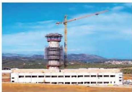
Στόχος της ΓΕΚ ΤΕΡΝΑ να παραδώσει ολοκληρωμένο εντός του 2026 στην ΥΠΑ τον πύργο ελέγχου, ύψους 44 μέτρων.
