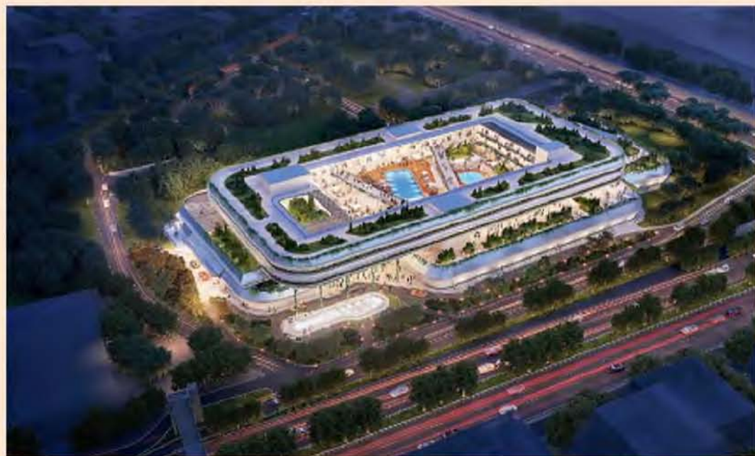
Μία από τις σημαντικότερες νέες συμβάσεις που υπέγραψε εντός του 2026 η ΜΕΤΚΑ αφορά το έργο VORIA Project στο Μαρούσι, που περιλαμβάνει την κατασκευή ενός ολοκληρωμένου συγκροτήματος φιλοξενίας, ψυχαγωγίας και ξενοδοχείου πέντε αστέρων.
