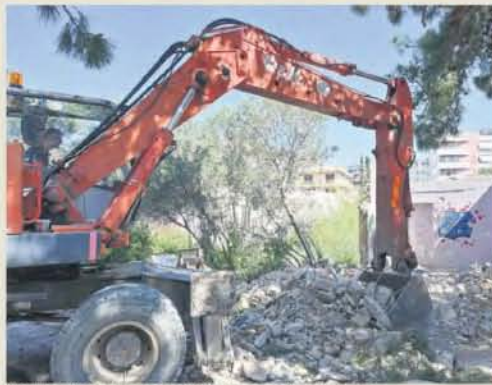
Κρίσιμη απόφαση για την απελευθέρωση της ροής του ρέματος.
