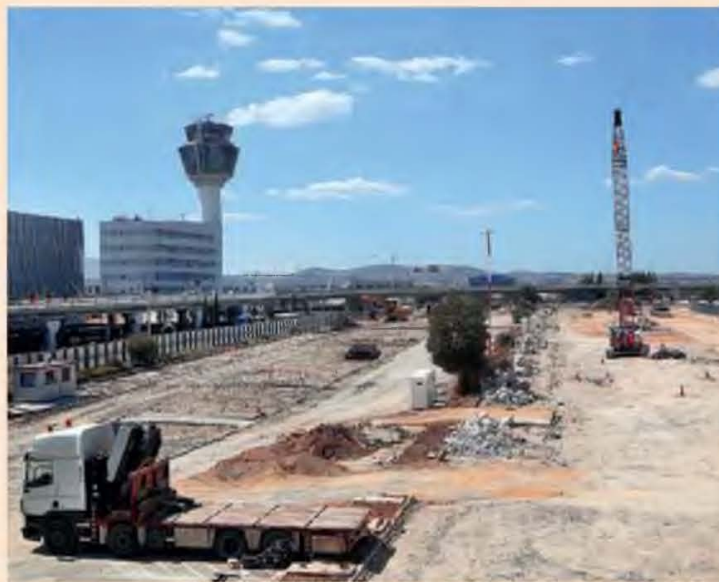
Το 2025 ξεκίνησε η κατασκευή του νέου πολυώροφου χώρου στάθμευσης οχημάτων και ενός βορειοδυτικού χώρου στάθμευσης αεροσκαφών.
