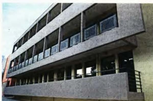
Το κόστος της κατασκευής και λειτουργίας φοιτητικών εστίων μέσω ΣΔΠ ανέρχεται στα 105,34 εκατ.
