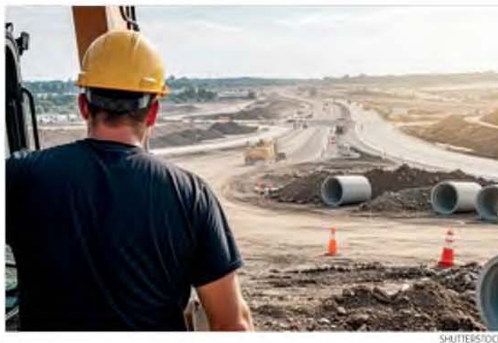
Τα έργα αφορούν την κατασκευή της σήραγγας Ηλιουπόλεως, τις επεκτάσεις της Αττικής Οδού και του νέου οδικού άξονα Ελευσίνας - Οινόφυτων.
