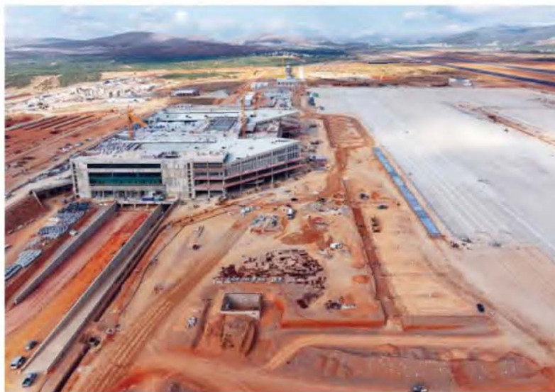
Το υπό κατασκευή αεροδρόμιο στο Καστέλι Ηρακλείου θα επισκεφθεί σήμερα ο πρωθυπουργός.
