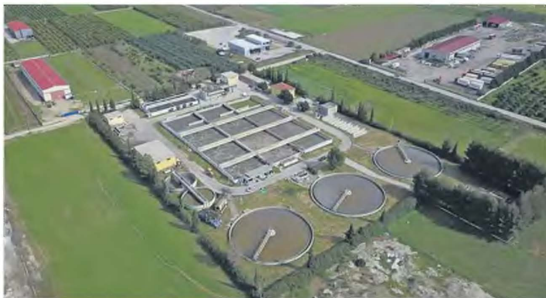
Υψίστης σημασίας η κατασκευή του νέου εργοστασίου επεξεργασίας της λυματολάσσης στις Εγκαταστάσεις Επεξεργασίας Λυμάτων Αργούς και Ναυπλίου.
