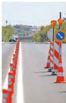
Το έργο της παραχώρησης περιλαμβάνει την κατασκευή 43 ανισόπεδων κόμβων, 23 σπράγγων και 89 γεφυρών.
