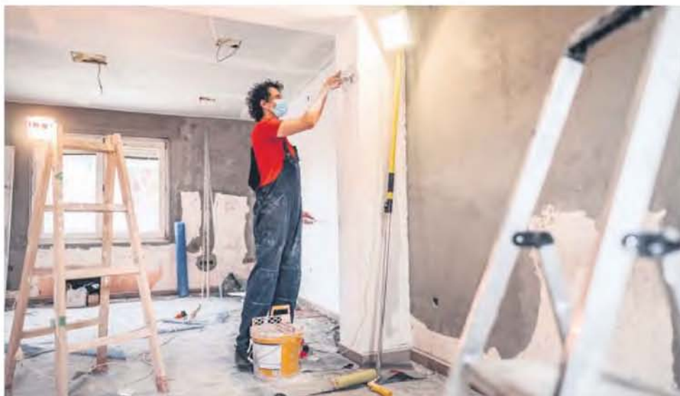
Αλλαγές σε πλακάκια, νέο πάτωμα, αντικατάσταση υδραυλικών δεν χρειάζονται άδεια πολεοδομίας.
