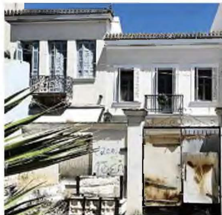
Το οικόπεδο επί της Βύρωνος, υφιστάμενη κατάσταση
