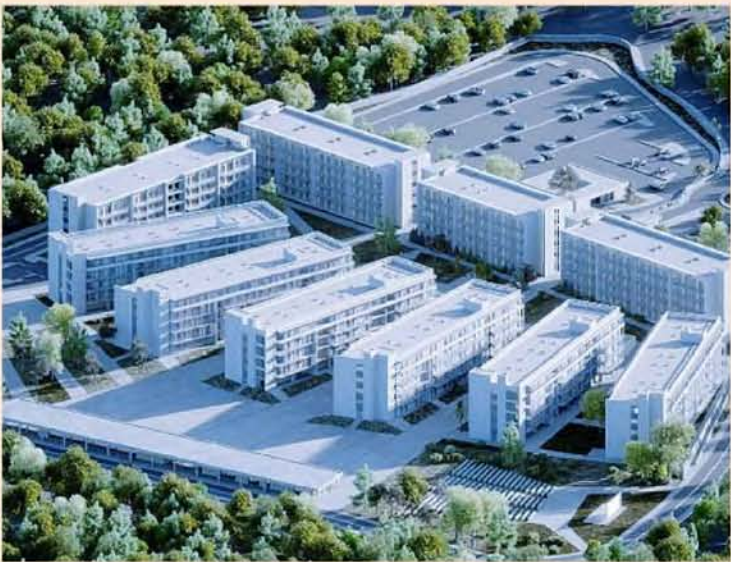
Το έργο ΣΔΙΤ φοιτητικών κατοικιών στο Ηράκλειο της Κρήτης αφορά την κατασκευή 1.016 διαμερισμάτων.
