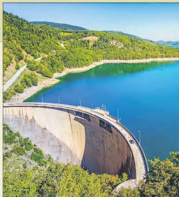
Δρομολογούνται έργα που θα προστατέψουν τη χώρα από το πρόβλημα της λιψιδρίας.
