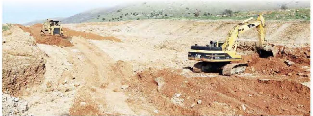
“Ωρολογιακή βόμβα” για τα δημόσια έργα και στο νησί μας αποτελεί η μεγάλη καθυστέρηση που παρατηρείται στην πληρωμή τους, με τον κατασκευαστικό κλάδο δημοσίων έργων να βρίσκεται στην πιο δεινή θέση της τελευταίας δεκαετίας.
