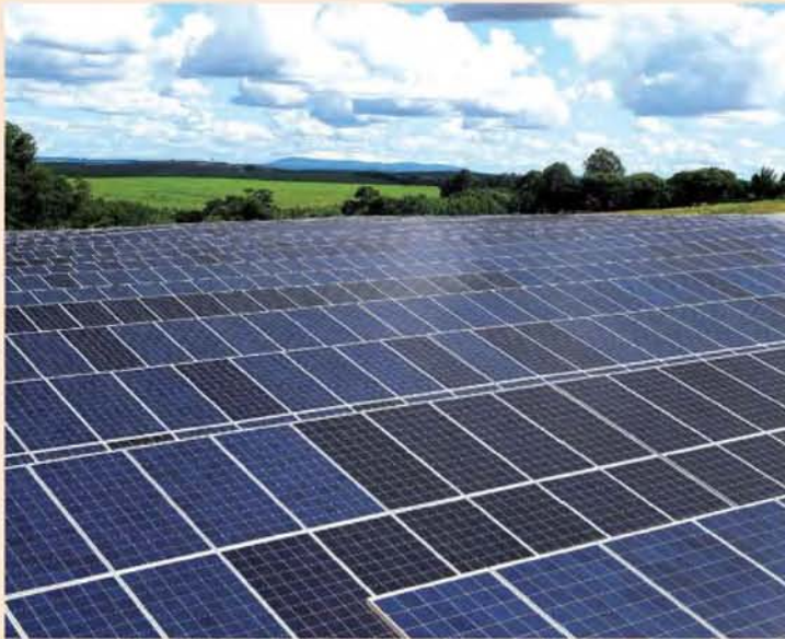
Εως το 2030 τα συνολικά χαρτοφυλάκια έργων της ΤΕΡΝΑ Ενεργειακής αναμένεται να αγγίξει τα 6 GW, μέσω της υλοποίησης ενός επενδυτικού προγράμματος ύψους άνω των 4-5 δισ. ευρώ, με έμφαση σε τομείς όπως η αποθήκευση ενέργειας, τα υπερκρία ατομικά πάρκα και τα φωτοβολταϊκά πάρκα.
