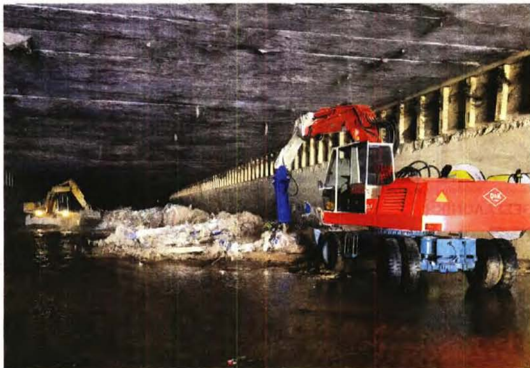
Εργασίες καθαρισμού σε όλα τα πλακοσκεπή τμήματα του Κηφισού, για πρώτη φορά έπειτα από σχεδόν τρεις δεκαετίες.
