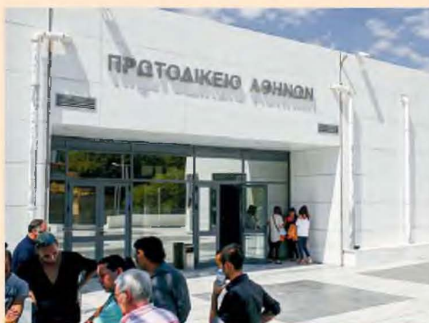
Τον διαγωνισμό για το ΣΔΙΤ του Πρωτοδικείου και της Εισαγγελίας Αθηνών, ύψους 254,46 εκατ. ευρώ, διεκδικούν οι Αβαξ, Ακτωρ Παραχωρήσεις, ΓΕΚ ΤΕΡΝΑ, Metlen, Ακτωρ - ΤΕΚΑΛ.
