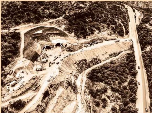
Εντός χρονοδιαγράμματος η ολοκλήρωση των έργων στον ΒΟΑΚ
