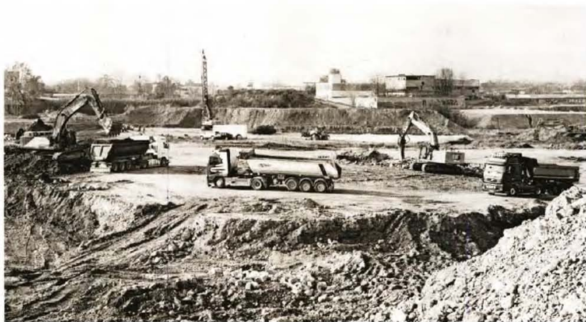
Μεταφορές εκσκαφής στον Βοτανικό για το νέο γήπεδο του Παναθηναϊκού
