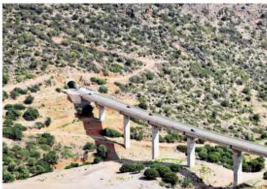
Η Δικταίον Παραχώρησης θα αναλάβει το project κατασκευής.
