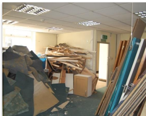
Διαχωρισμός στην πηγή σε εργοτάξιο κατεδάφισης. Πηγή: UEPG
