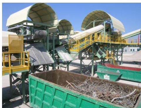
Μονάδα ανακύκλωσης αποβλήτων Κ&Κ. Πηγή: ANPAR
