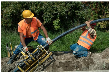
Προϋπολογισμός 32,2 εκ. €, Ενίσχυση WBIF 2,6 εκ. €, αναμενόμενη ολοκλήρωση 2025
